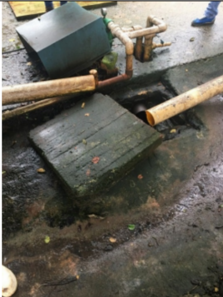
Fotografía 6. Descarga del ARND del tanque de almacenamiento de la PTAR
