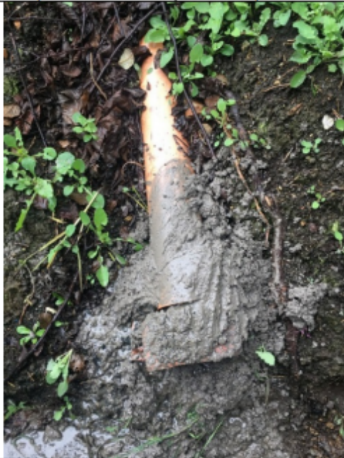
Fotografía 18. Taponamiento de la descarga 4 (ARnD lixiviado de lodos.)
