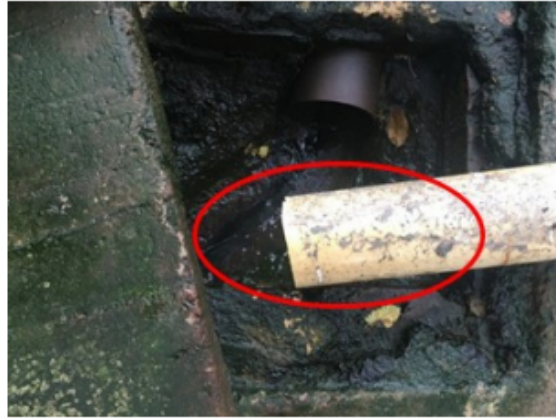
Fotografía 7. Descarga de lixiviados de los lodos generados por la PTAR
