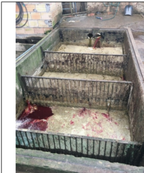
Fotografía 1. Agua residual no doméstica del área de producción. (Rejillas y trampa de grasas.)
