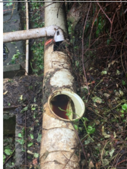
Fotografía 7. Descarga de lixiviados de los lodos generados por la PTAR
