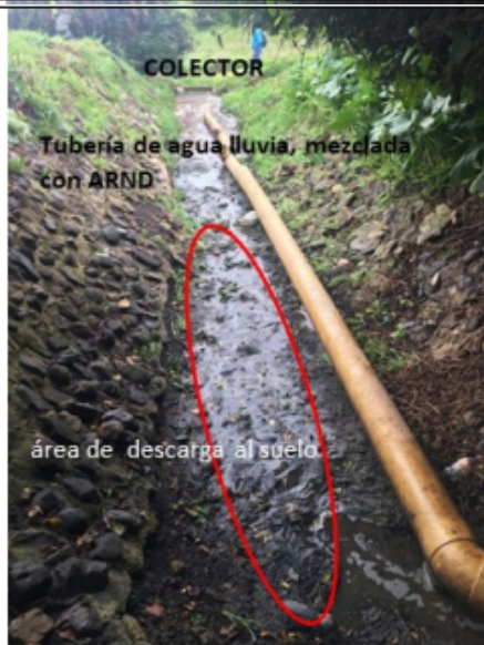
Fotografía 6. Descarga del ARND del tanque de almacenamiento de la PTAR
