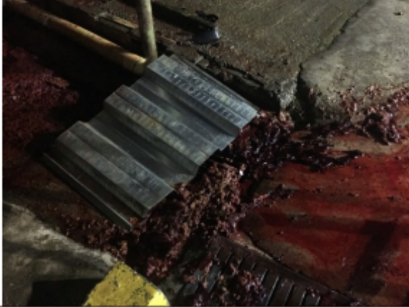
Fotografía 10. Residuos de sólidos, a la intemperie
